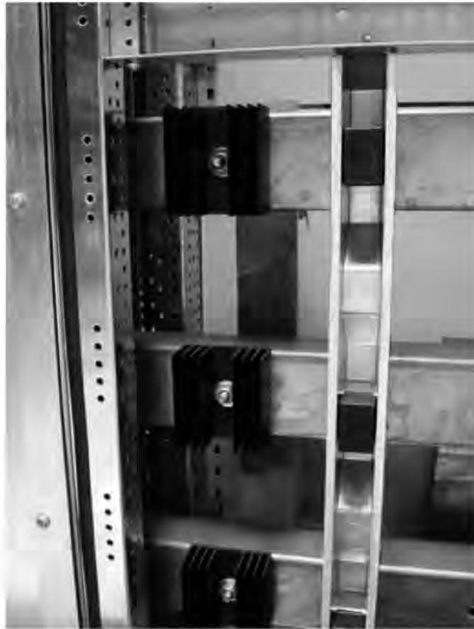
Figure 12.16 – Utilisation de radiateurs sur les barres (Moeller Electric).
