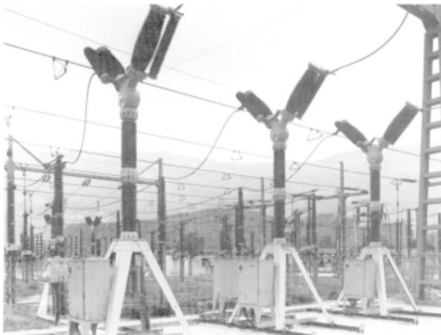
Fig. 10 : disjoncteur 245 kV à SF 6 .
