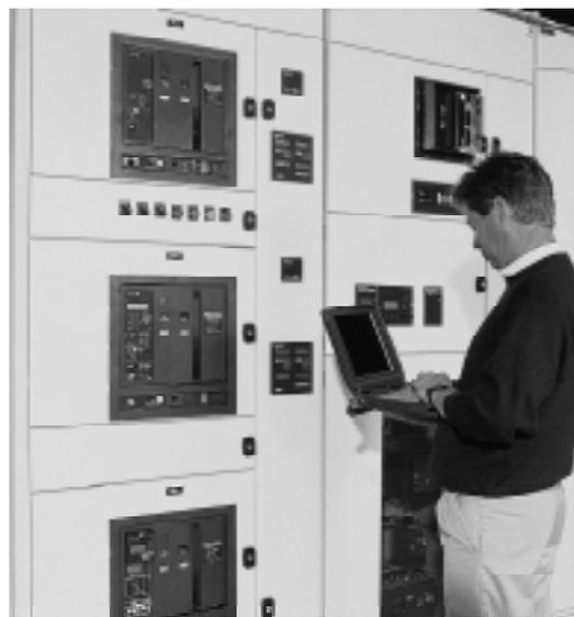
**Fig. 1** : l'intelligence est maintenant intégrée dans les tableaux BT (Digibloc - Merlin Gerin).
