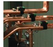
Jeu de capteurs Easergy TH110 fixés sur les 3 phases d'un raccordement électrique
