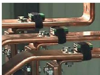
Figure 1.8. Lot de capteurs Easergy TH110 fixés sur les 3 phases d'une connexion électrique
